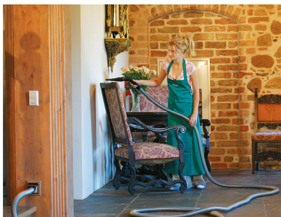
System centralnego odkurzania w hotelu CEDYNIA
