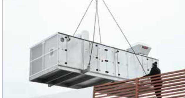
Ustawienie przy pomocy dźwi- gu urządzenia na dachu filii gastronomii systemowej
