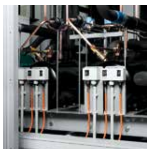
Wbudowany agregat chłodniczy (grzewczo - chłodzący)
